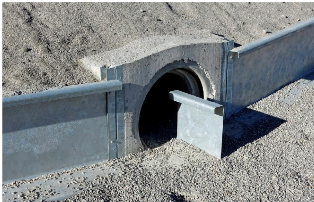
Figur 3. Exempel utformning av grodtunnel.
